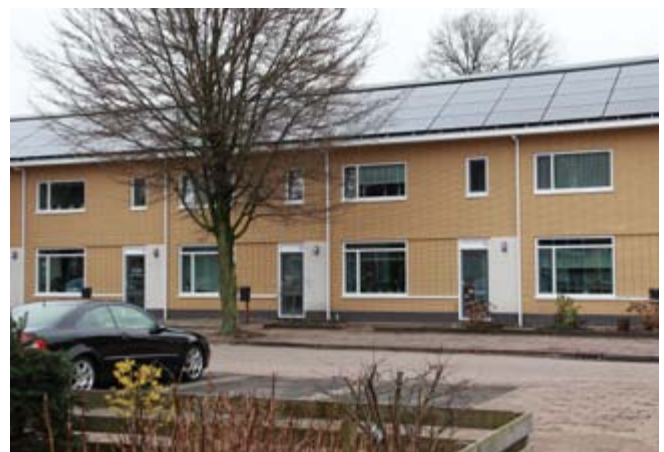
Project van BAM woningbouw in Soesterberg
