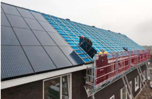
Montage van zonnepanelen bij een project van VolkerWessels
